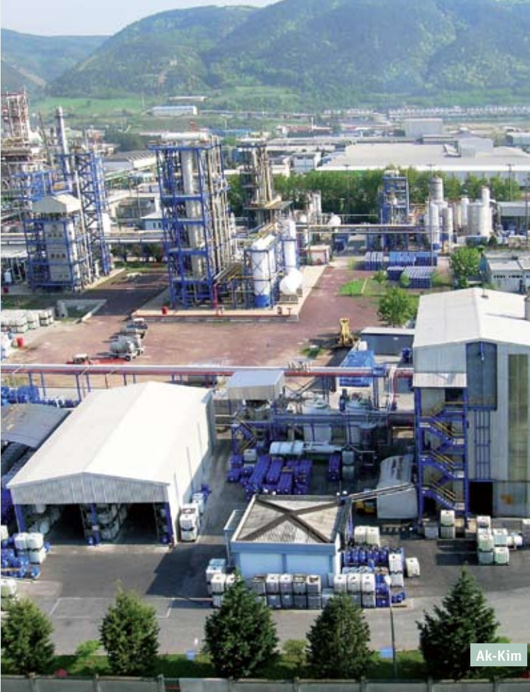
Aksa Karbon Elyaf Tesisi
